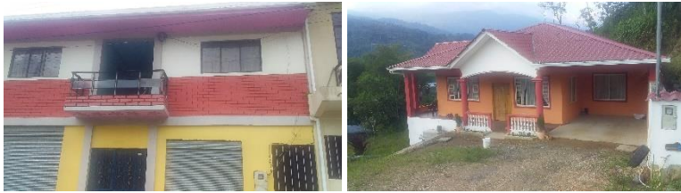
Fotos 46. Edificaciones en estado Bueno
