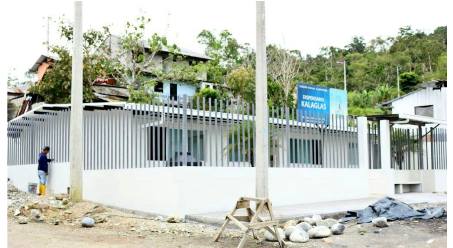
Fotos 44. Puesto de salud del IESS. Unión Kalaglás
