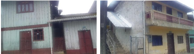
Fotos 47. Edificaciones en estado regular
