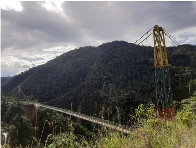
Fotos 23. Puente Pasarela Kutukus
